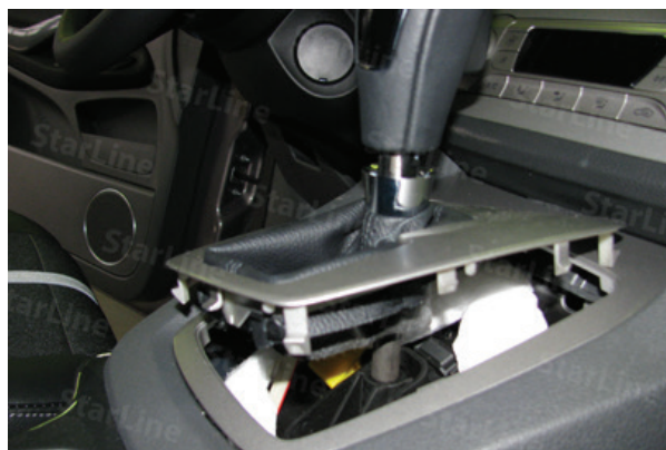
Фото 1.3. Отщёлкиваем облицовку селектора
