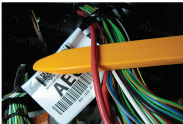
Фото 12.1. Постоянный плюс (красный)
