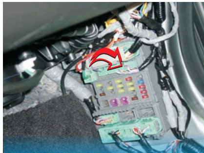
Подключение у блока предохранителей, расположенного в ногах переднего пассажира
