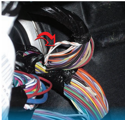
Подключение в жгуте водительской двери, находящемся за левой боковой накладкой в ногах водителя
