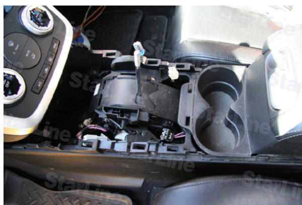
Фото 1.3. Демонтаж горизонтальной части тоннеля
