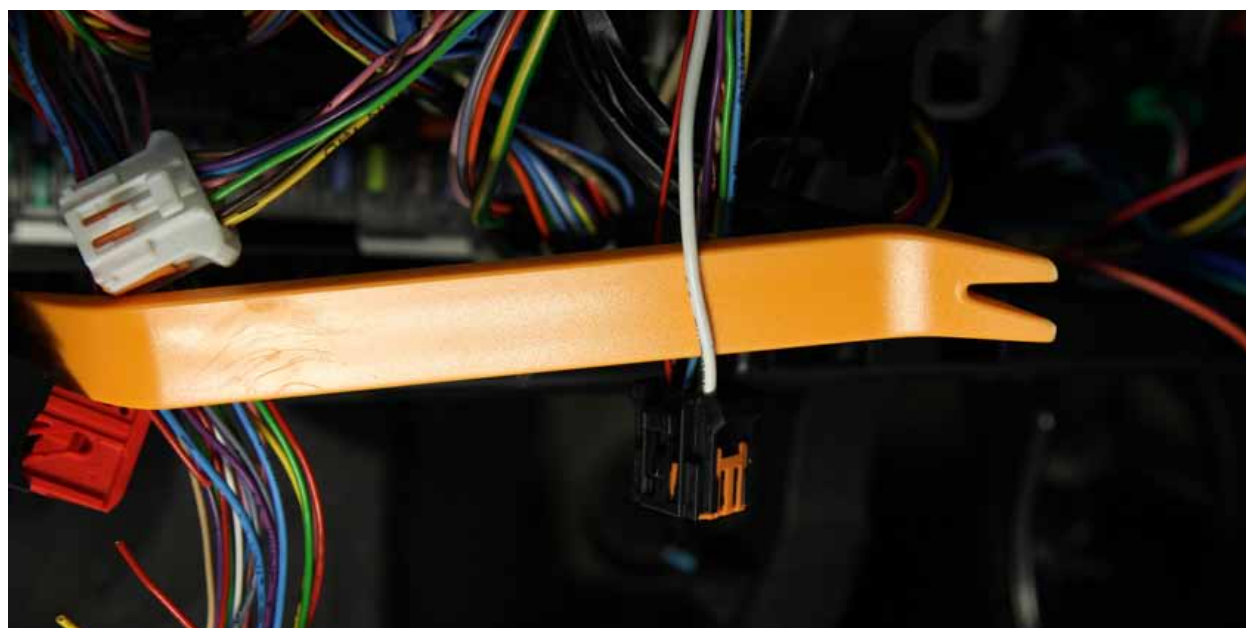
Фото 14. Подключение плюса питания сигнализации
